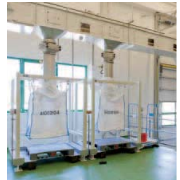
Die gerösteten Nüsse werden in Big Packs gefüllt
